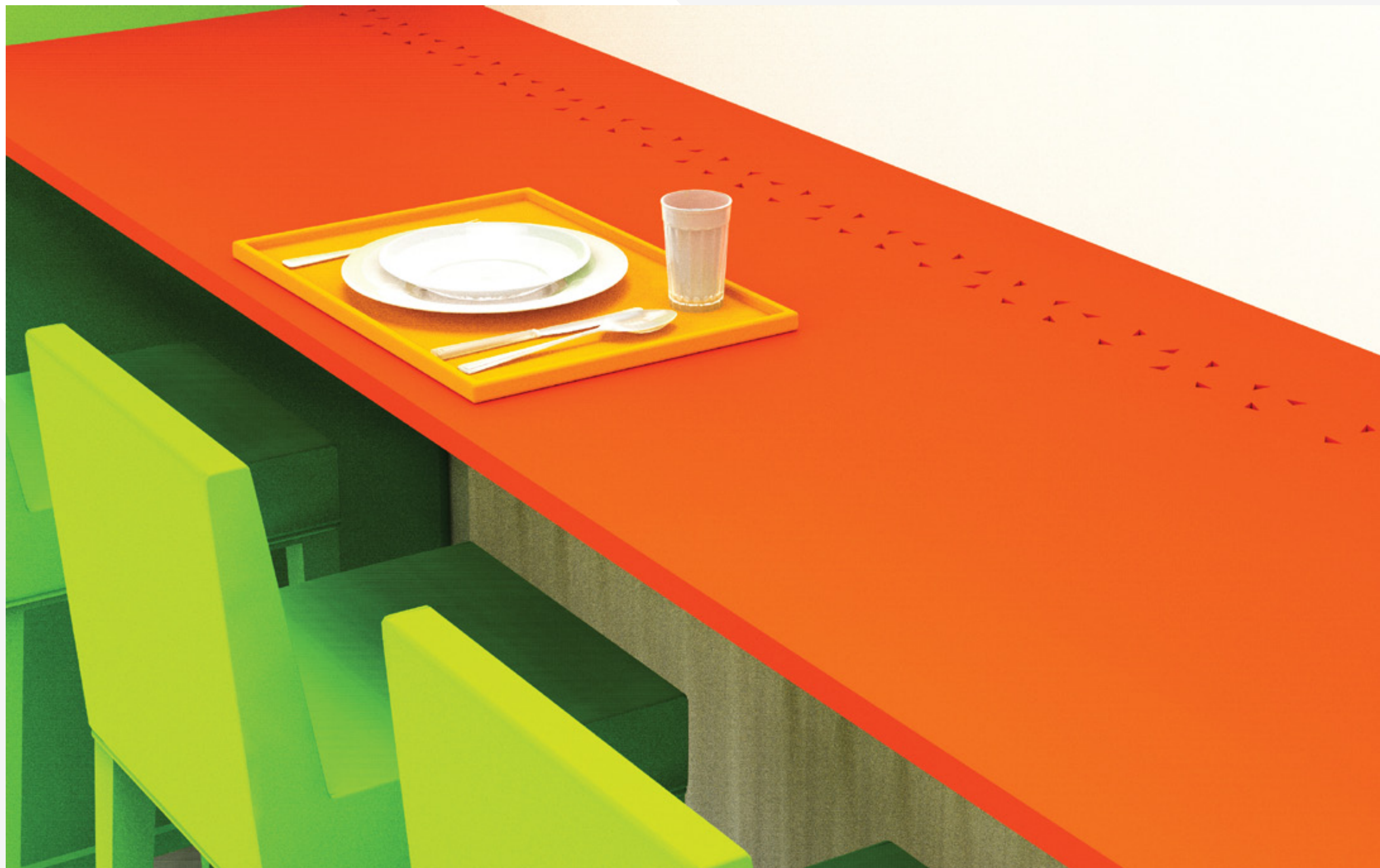
Perforace v parapetech nad radiátory
